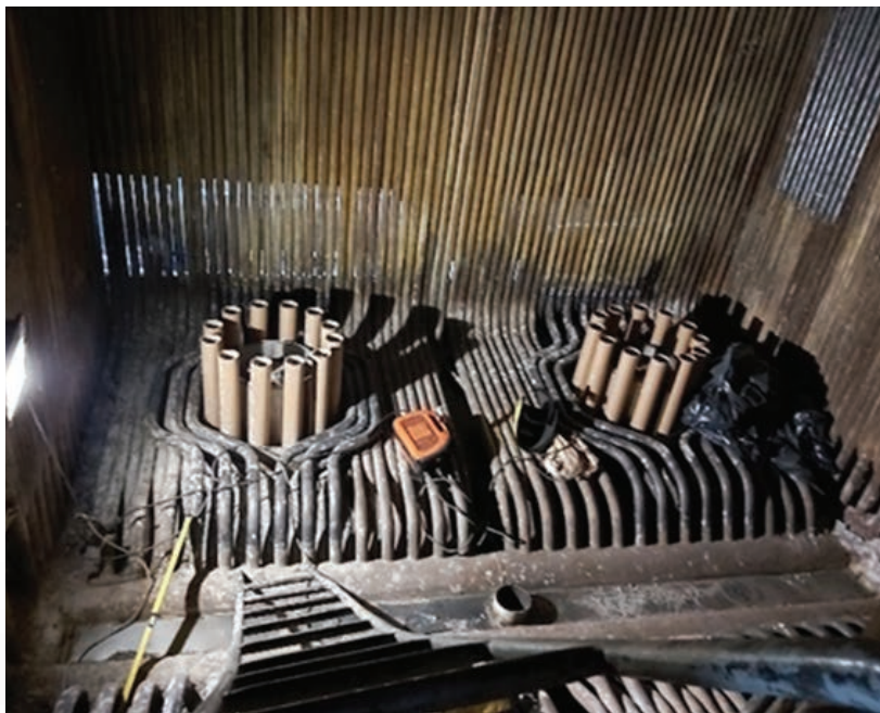
6. ábra. A PTVM-50 kazán eredeti oldalégős kialakítása és a legelönyösebb fenékégős kialakításra történő átalakítás fotója
